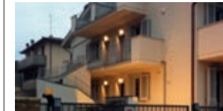
Una realizzazione di Edil 84
